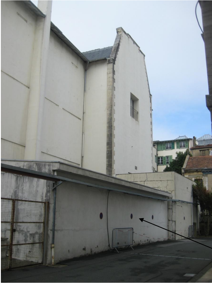
Bâtiment à démolir et à reconstruire
